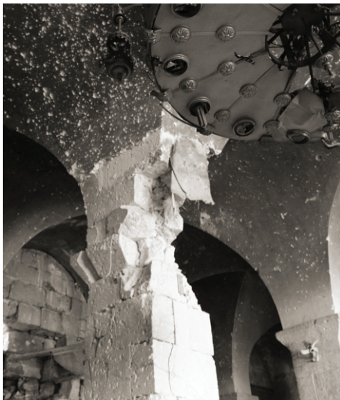
Grande Mosquée d'Alep. En haut à gauche : Dommages à l'entrée ouest de la Grande Mosquée. Date de la photo : 16 janvier 2017 © UNESCO/G. Khawam. En bas à gauche : Pilier endommagé dans la salle de prière principale de la Grande Mosquée. Date de la photo : 16 janvier 2017 © UNESCO/G. Khawam. En bas à droite : Un des mihrabs de la salle de prière de la Grande Mosquée. Date de la photo : 16 janvier 2017 © UNESCO/G. Khawam. À droite : Barils installés à des fins de protection dans la salle de prière de la Grande Mosquée. Date de la photo : 16 janvier 2017 © UNESCO/G. Khawam.
