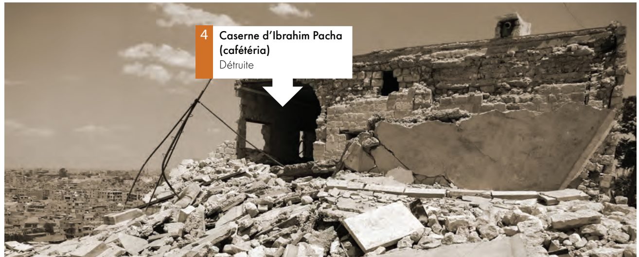
Caserne d'Ibrahim Pacha (cafétéria). Photo prise depuis le côté ouest de la caserne d'Ibrahim Pacha en direction de l'extrémité ouest du bâtiment, qui a été complètement détruite. Date de la photo : 28 mai 2017 © Art Graphique & Patrimoine.
