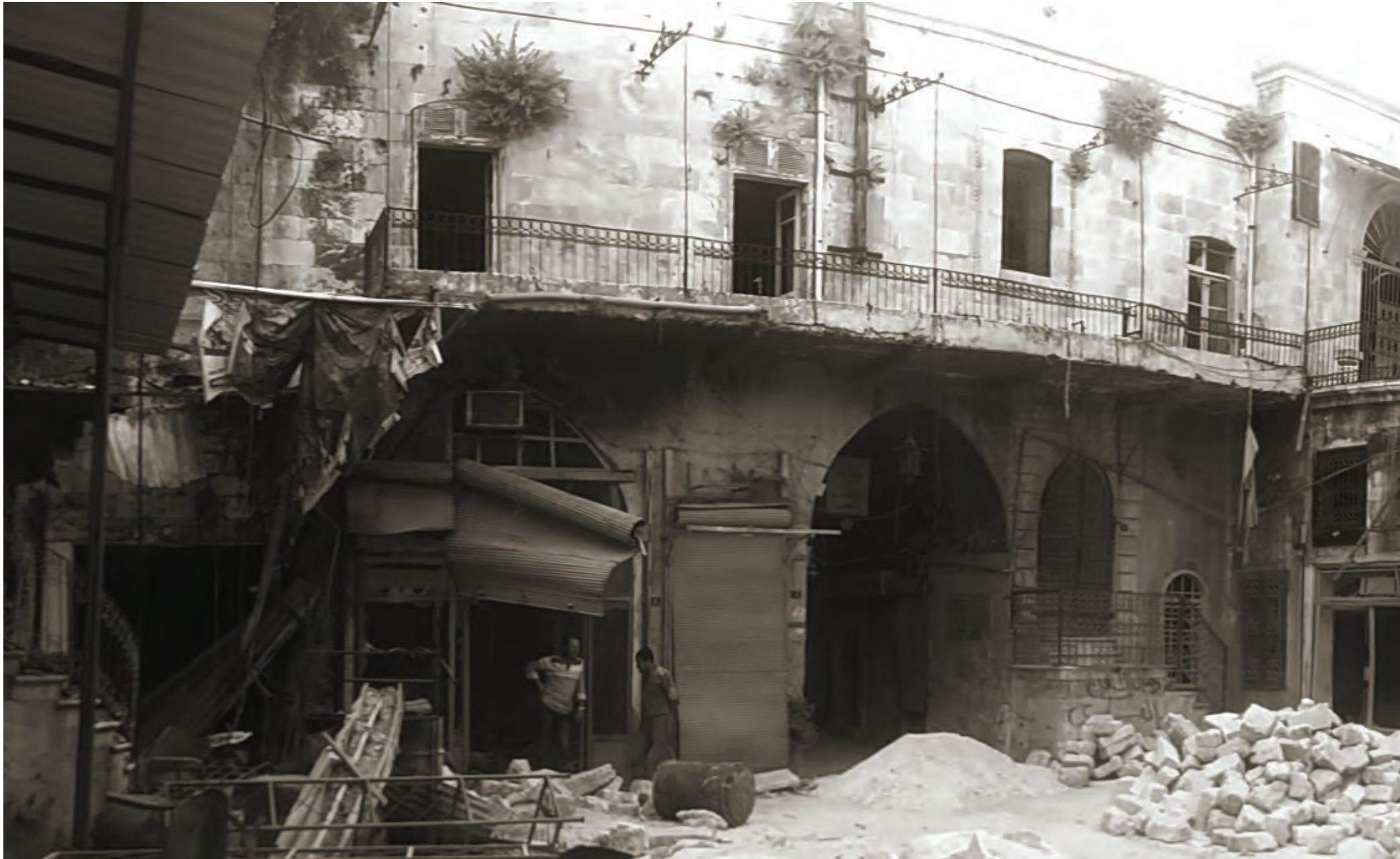
Cour intérieure du Khan al-Nahhasin. Date de la photo : 14 juin 2017 © UNESCO/M. Samman.
