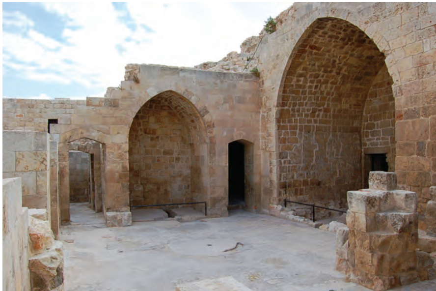
Palais al-Tawashi. Date de la photo : juin 2010 © Ross Burns.
