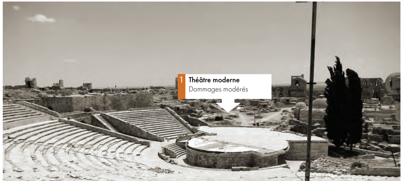
Théâtre moderne. Photo prise depuis la partie nord du théâtre moderne (milieu des gradins) en direction de l'orchestre. Date de la photo : 28 mai 2017 © Art Graphique & Patrimoine.
