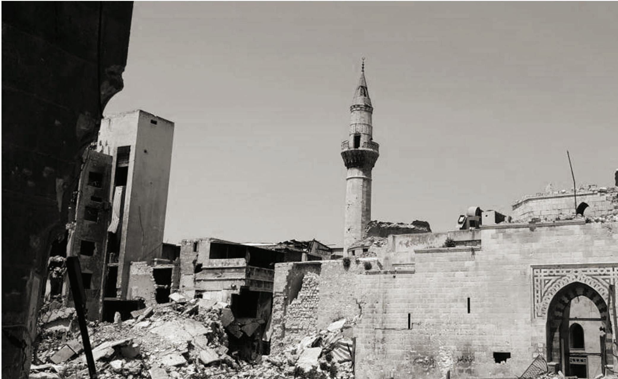
Façade principale du matbakh al-Ajami. Date de la photo : 16 janvier 2017 © UNESCO/C. Menegazzi.
