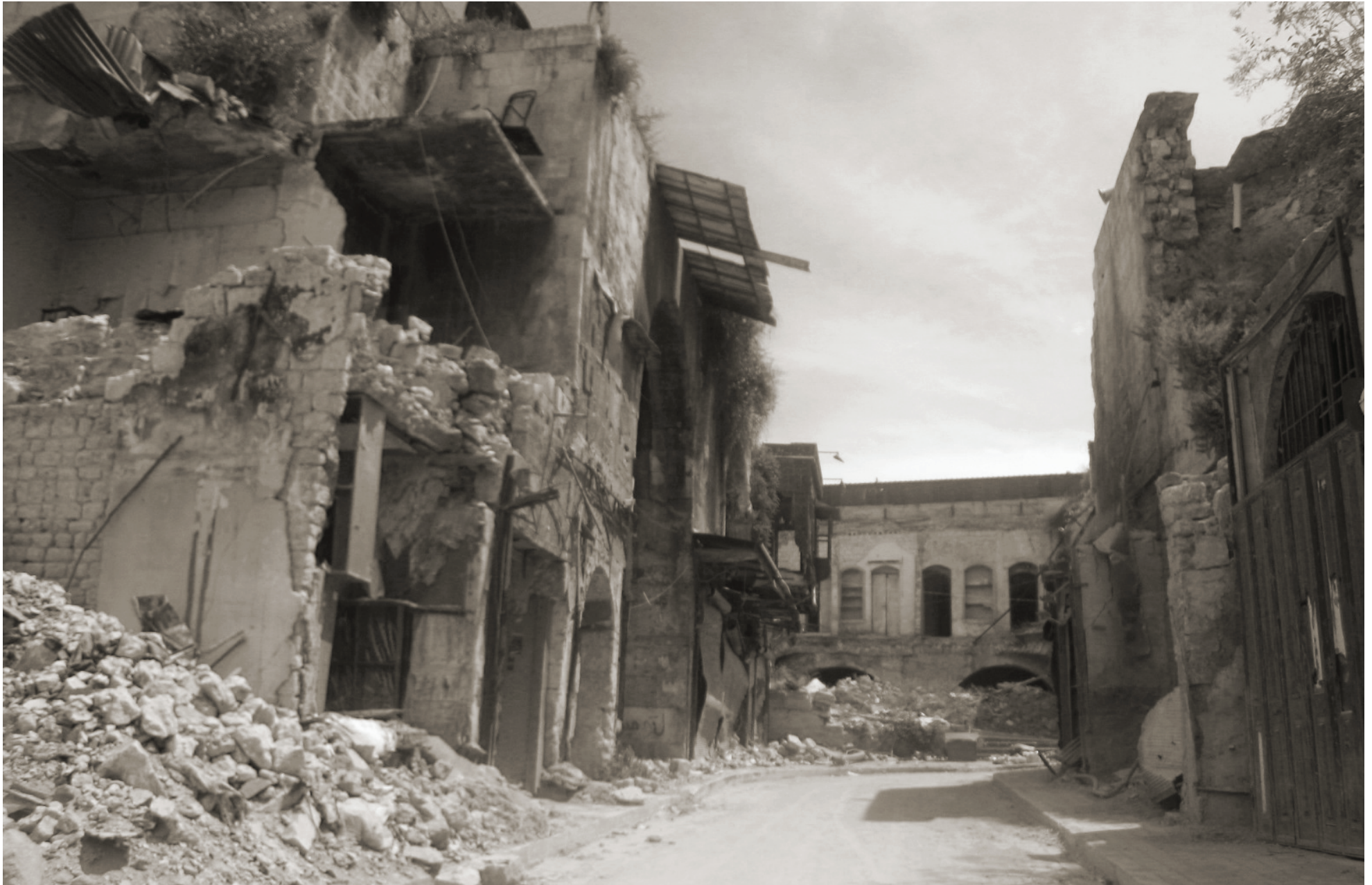
Bab al-Nasr. Vue de la porte en direction du sud. Date de la photo : 14 juin 2017 © UNESCO/M. Samman.
